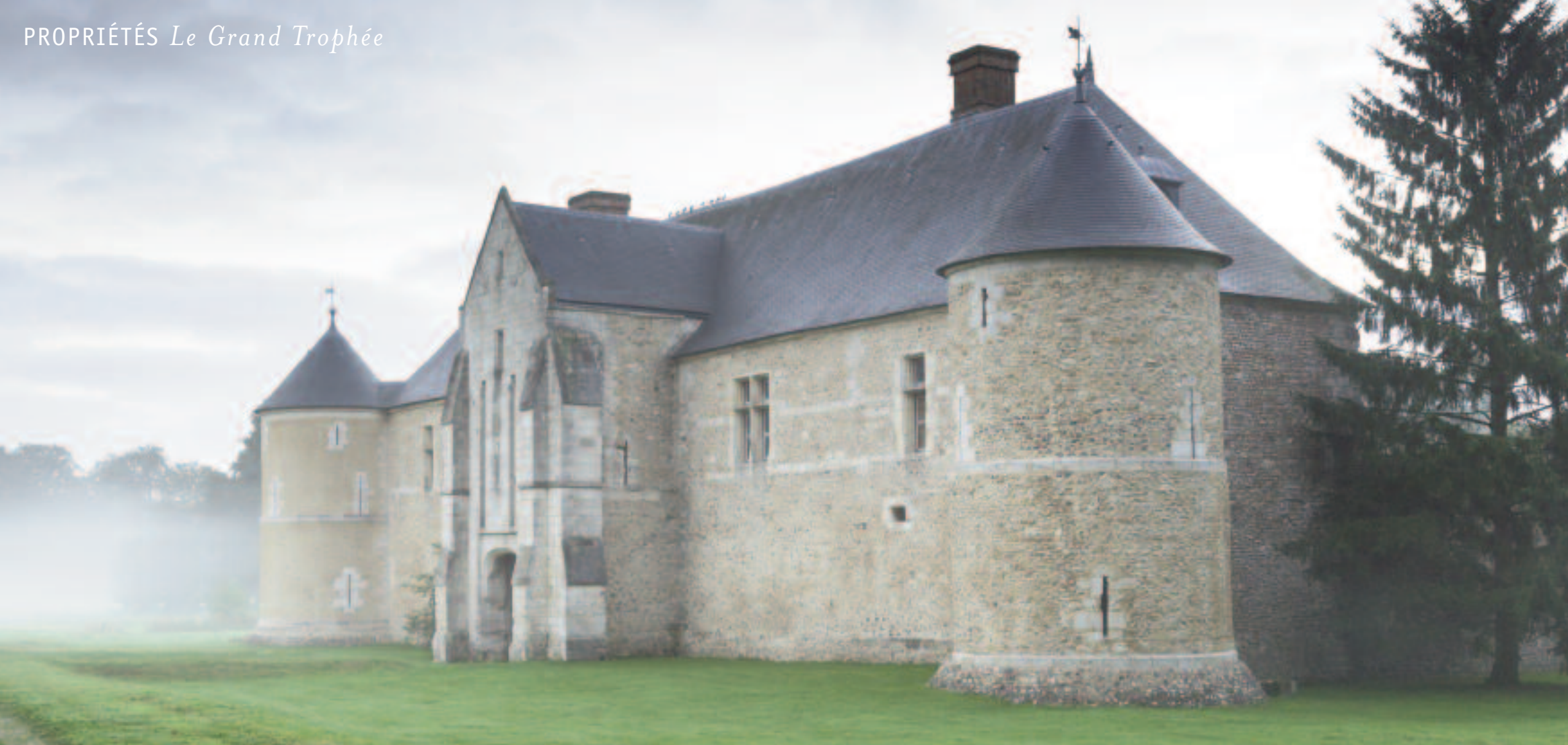
LA FAÇADE AVANT ÉTANT ACHEVÉE, DES FOUILLES ARCHÉOLOGIQUES RECHERCHENT DES TRACES DU PONT-LEVIS ET DES DOUVES AVANT LA RECONSTITUTION.
